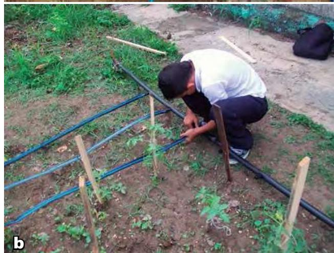
Foto 2 a y b. Estudiantes instalando el sistema de riego por goteo.
