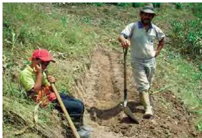
Foto 31. Construcción de la acequia con herramientas manuales.
