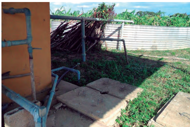
Foto 2. Sistema de recirculación que alimenta al tanque de cultivo.
